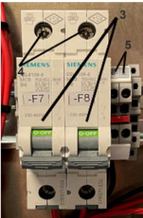
4. Contrôler que les disjoncteurs de ligne (F7 et F8) se trouvent en position « OFF » (3).
