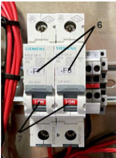
Fig. 52 : F7 et F8 en position « ON »
